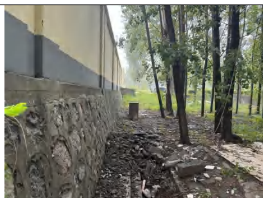
裴苑 220kV 变电站西侧植被现场图
