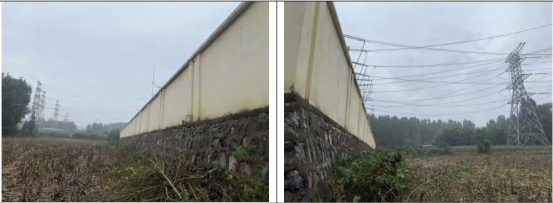
裴苑 220kV 变电站南侧植被现场图 裴苑 220kV 变电站东侧植被现场图
