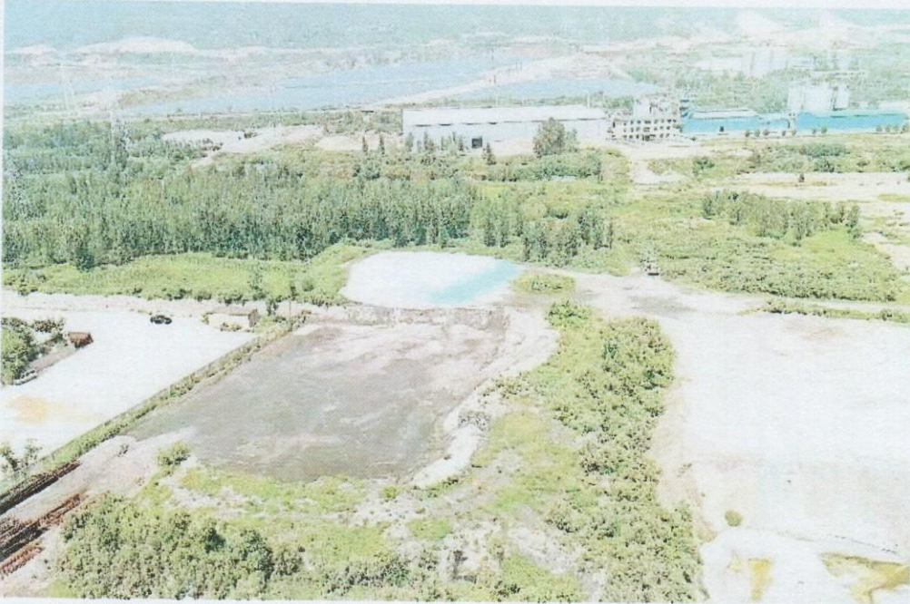
整治前-堆场西北角的 3000 吨炉渣
