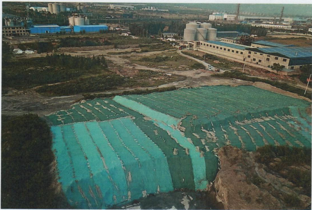
整治后-45000 吨脱硫石膏堆场已全部苫盖完成
