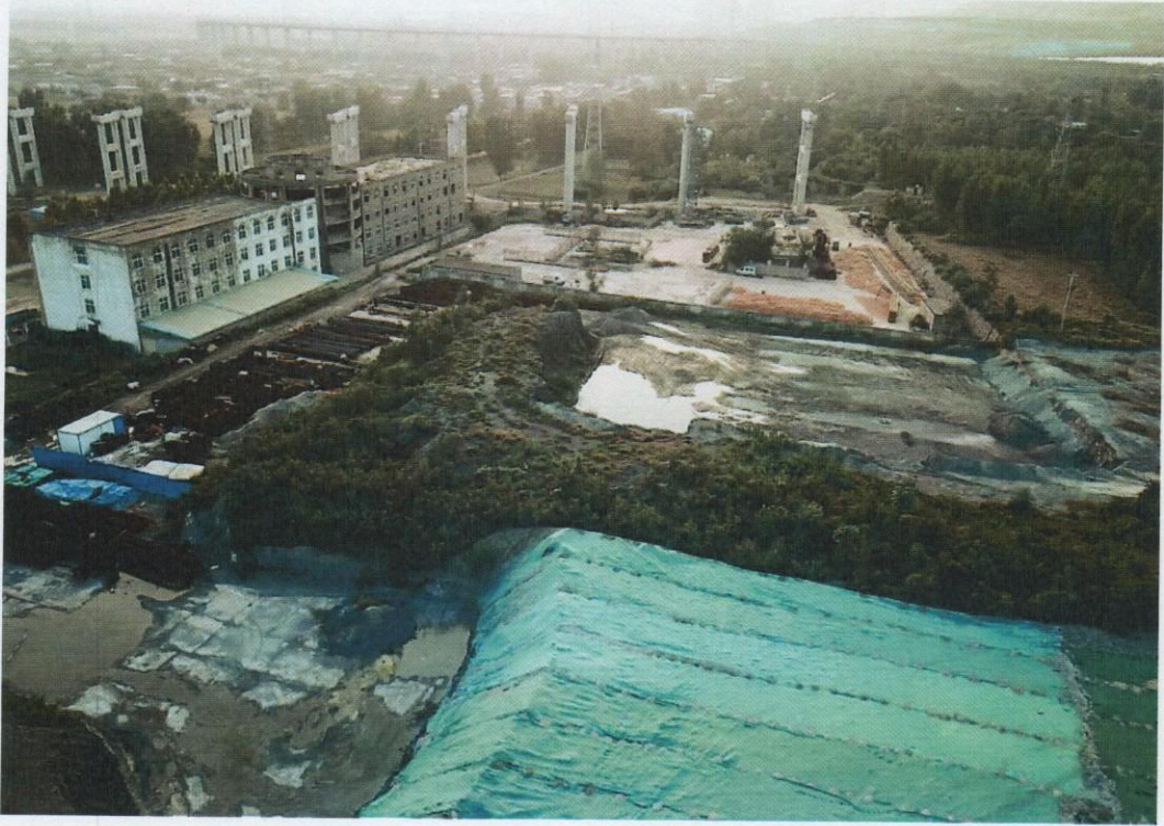
整治后-西北角 3000 吨炉渣已清运完成
