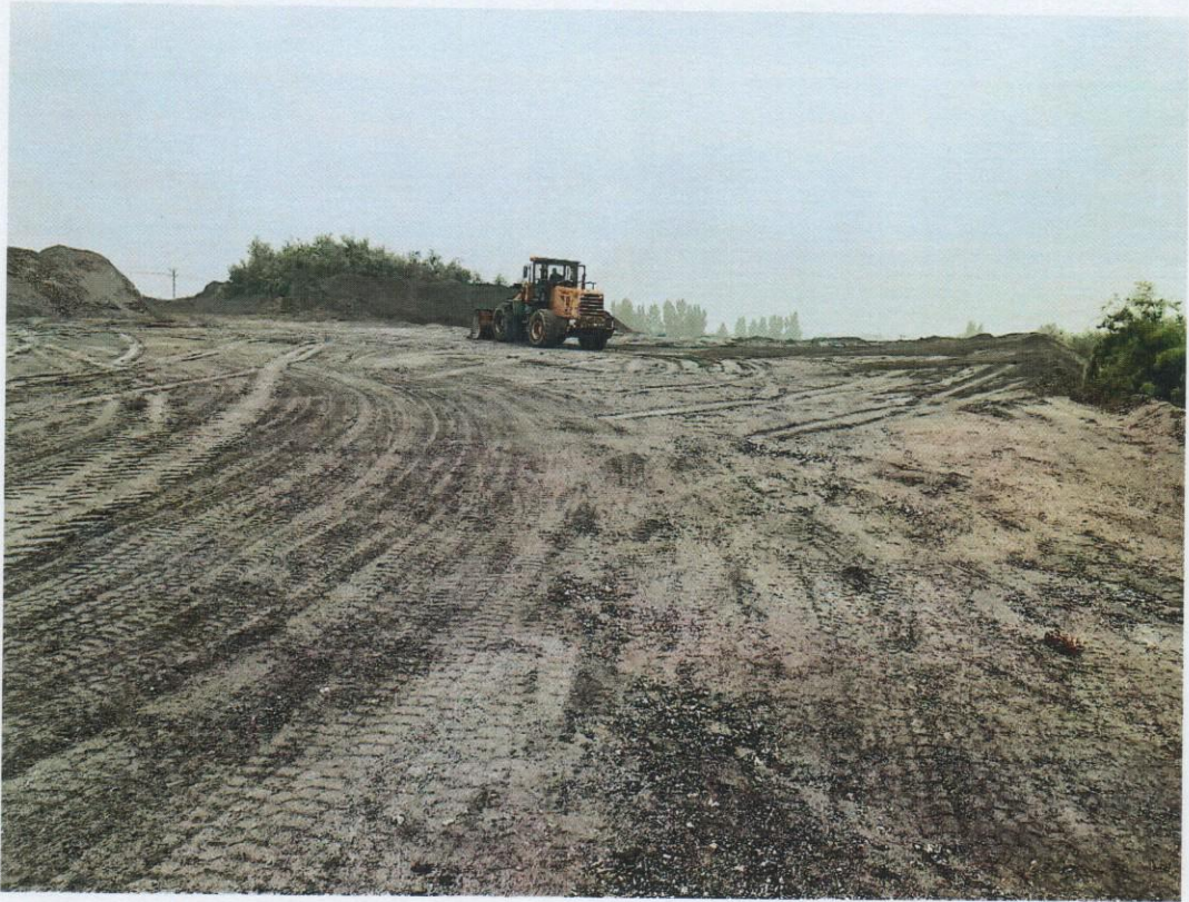
整治中-炉渣清运中
