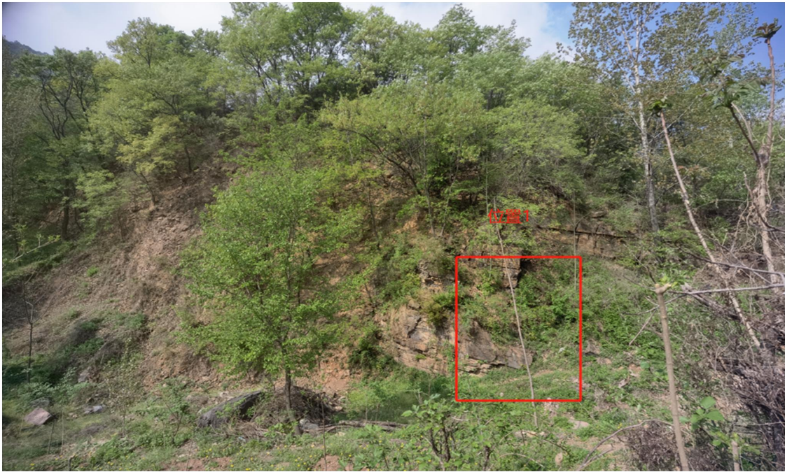
图 3-4 隧洞出水口位置 1 与冲沟现场图
