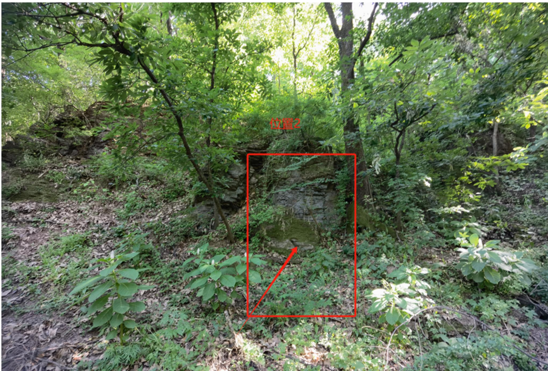
图 3-5 隧洞出水口位置 2 与冲沟现场图
