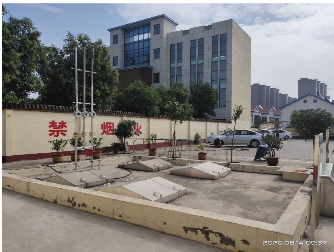
油罐区现场照片
