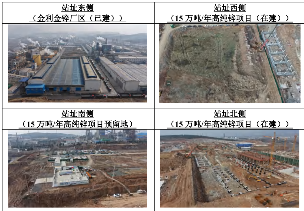
图 3-5 变电站站址现场照片
