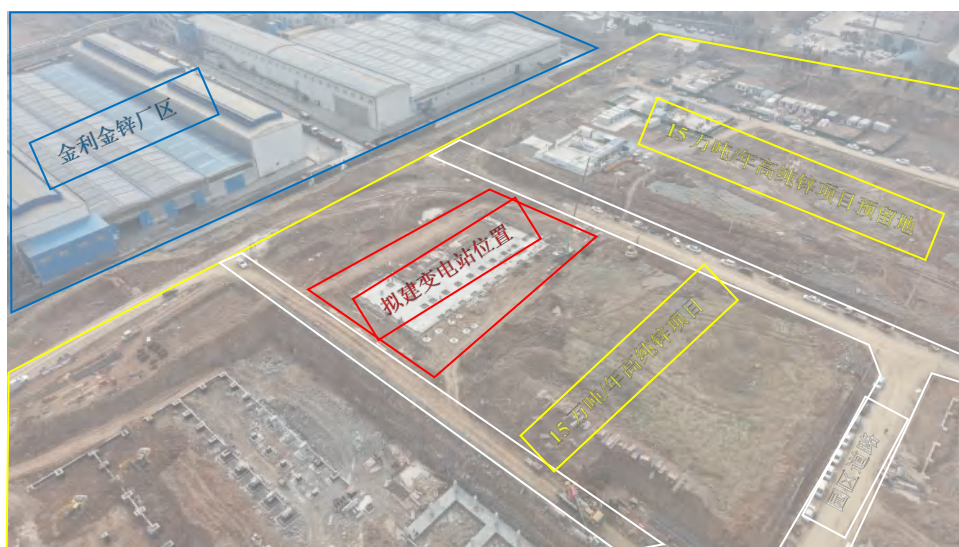
图 3-1 变电站周围现状照片
