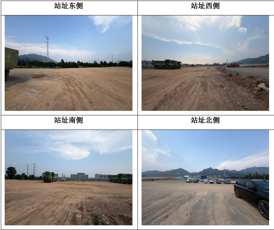
图 3-5 变电站站址现场照片
