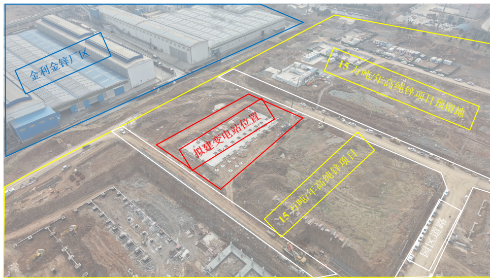
图 3-1 变电站周围现状照片
