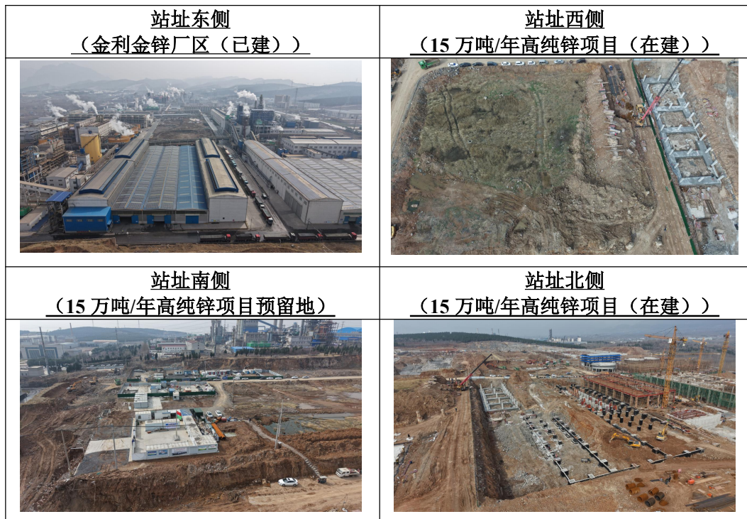
图 3-5 变电站站址现场照片
