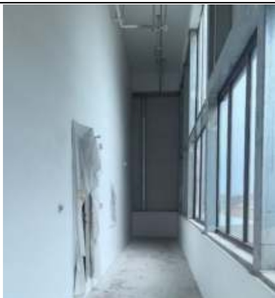
X 射线检测室外北侧走廊
