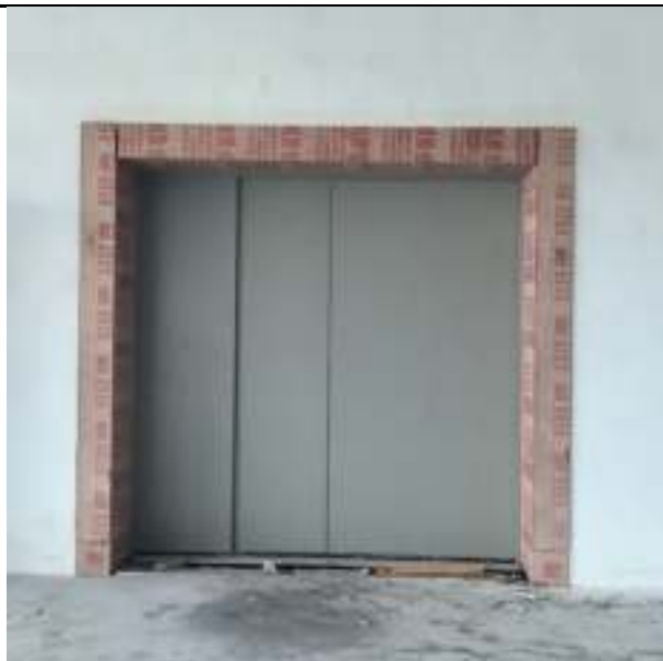
X 射线检测室外东侧电梯
